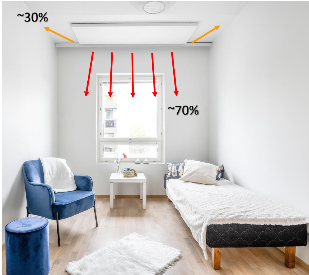
Radiant Ceiling Panels EN 14037
